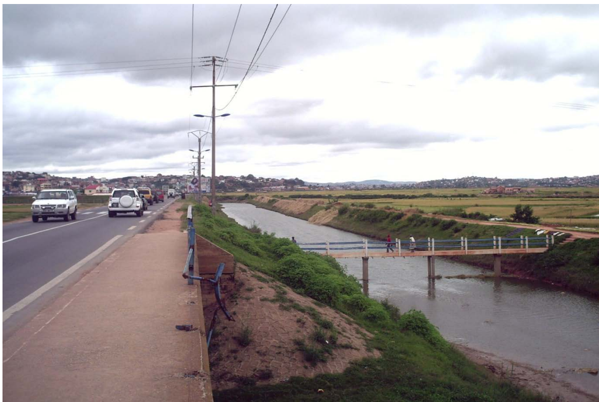
Photo montrant des infrastructures à Ambodimita : canal servant à évacuer l'eau accumulée dans la station de pompage, deux ponts, routes bitumées (Photo N°4 : Cliché de l'auteur en date du 23/12/2011)
