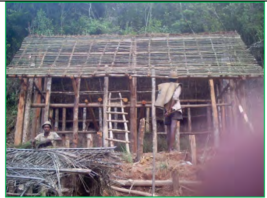
Photo 28 : Construction de cage en bois à Ranomena (Haonaso)
