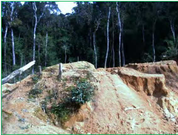
Photo 22 : Dégât de l'exploitation de corindon à Ihazomena (CMP)
