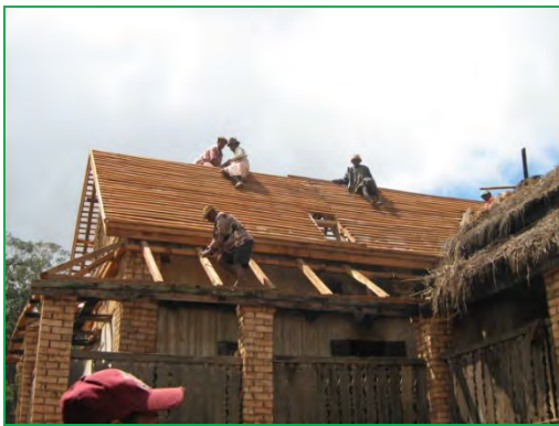
Photo 61 : Construction de toiture en bois d'eucalyptus à Miarinarivo (Haonaso)
