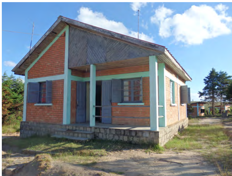
Photographie 2 : Photo du Bureau principal et l'entrée de l'AP
